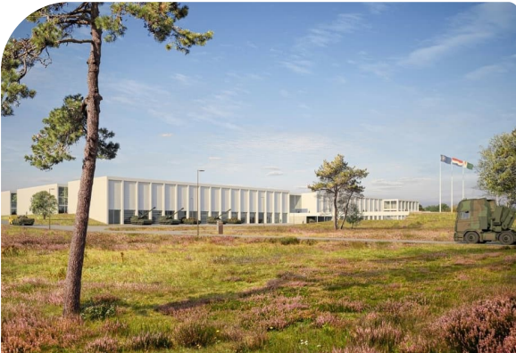
Start bouw Technologie Centrum Land voor Defensie in Leusden.
